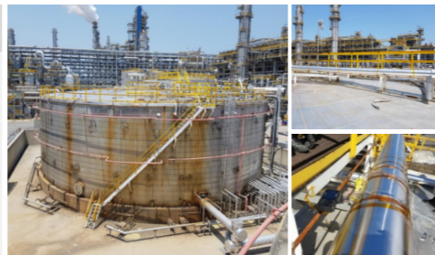
현대오일뱅크 황화수소 저장 Tank
